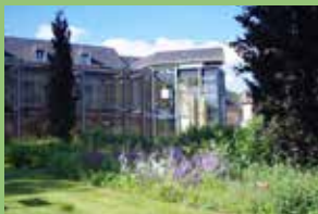
La médiathèque Andrée Chéid
